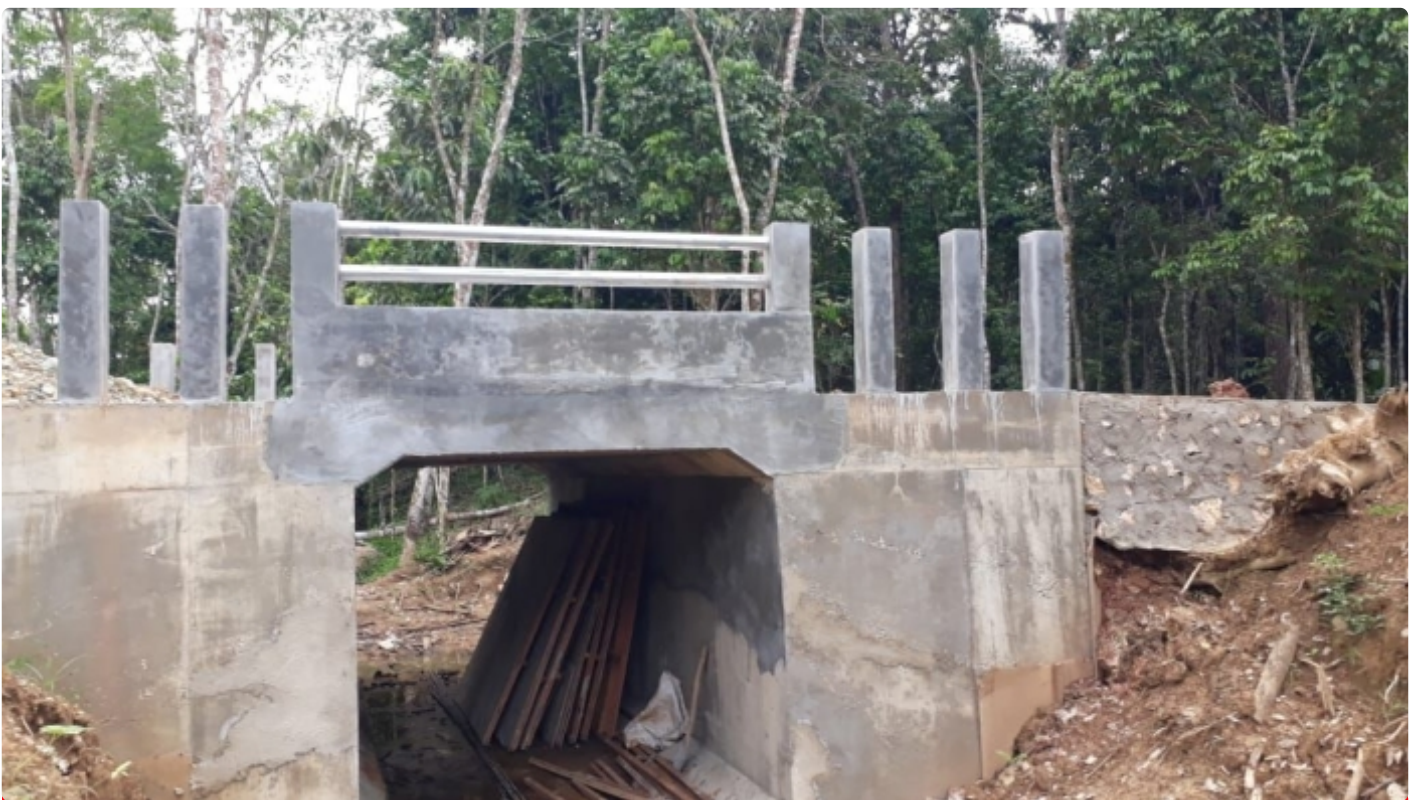
Jembatan Box Culvert Masuk Tahap Finishing
