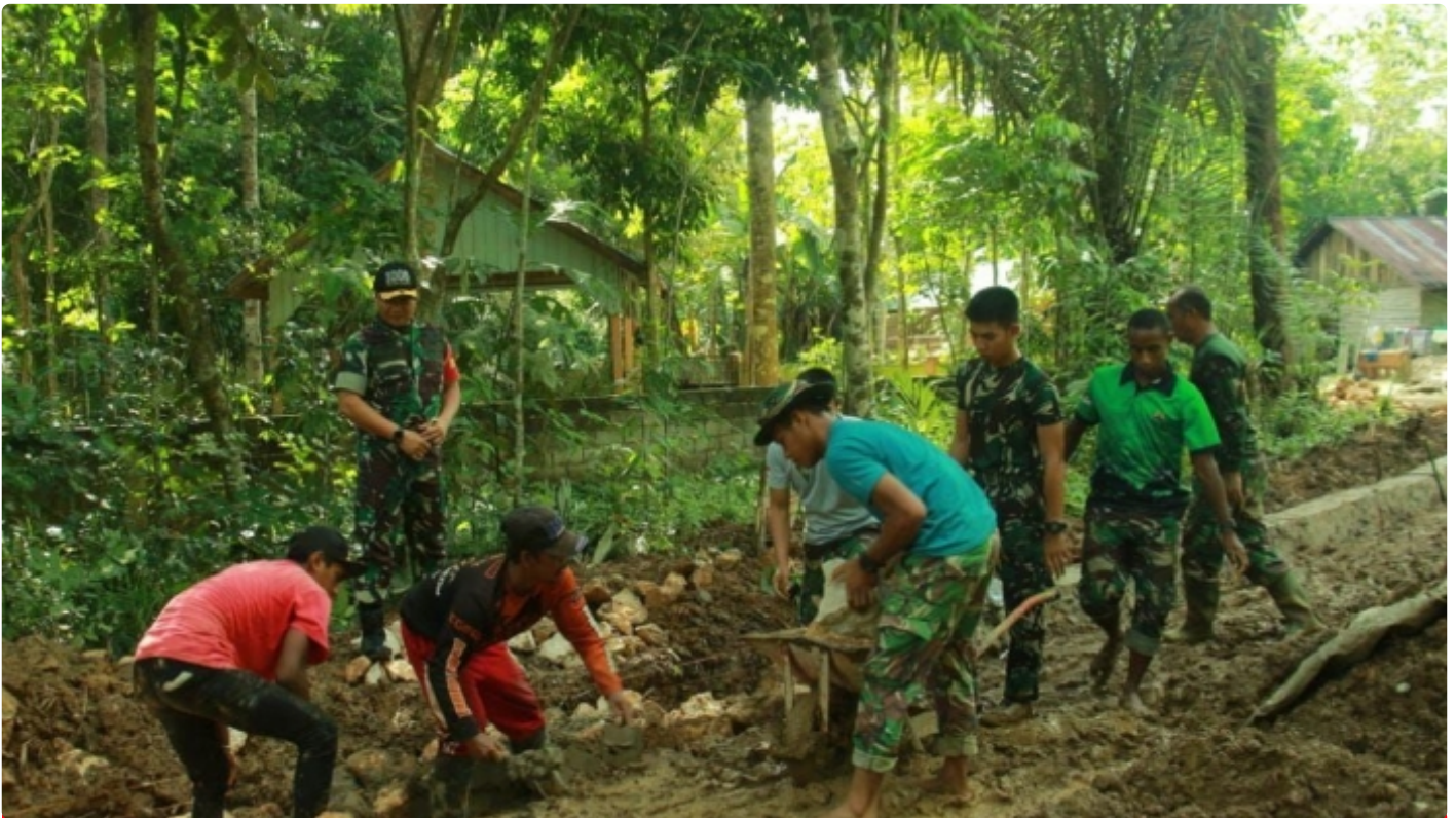
Dansatgas TMMD Kodim 1008 /Tabalong Tinjau Progres Pembuatan Badan Jalan
